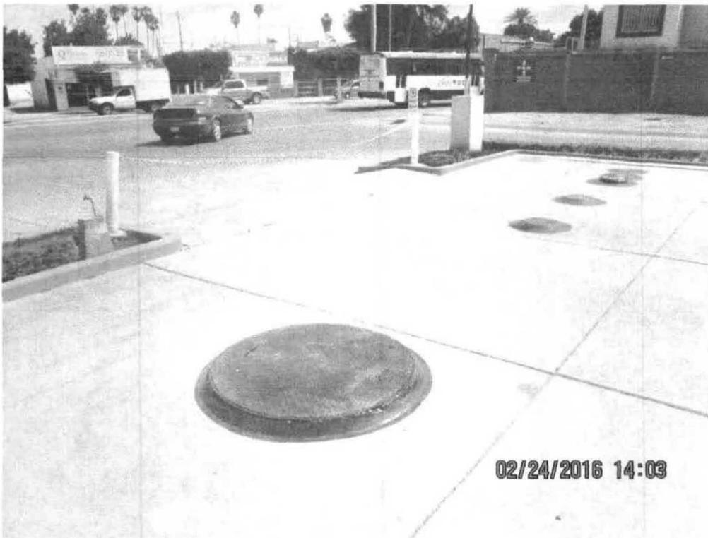
Fotografía No. 8.- Tapa de para acceso a tanque de almacenamiento de Diesel.
