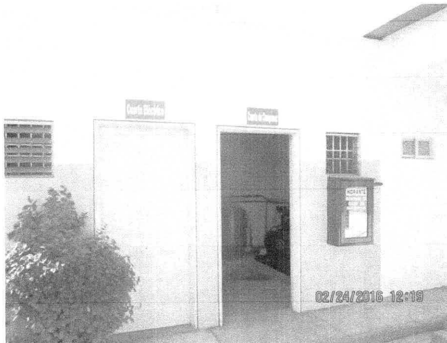
Fotografía No. 8.- cuarto de máquinas e instalaciones eléctricas
