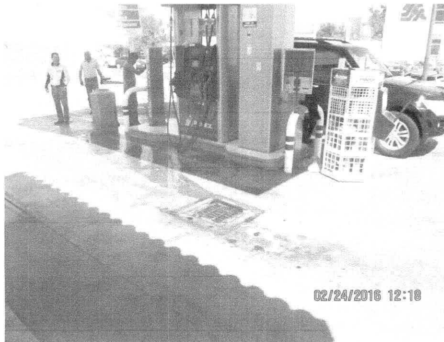
Fotografía No. 4.- colector de aguas accitosas y con combustibles.
