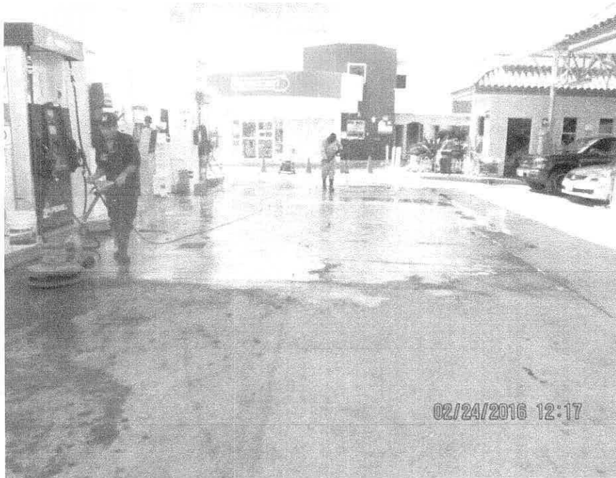
Fotografía No. 3.- Zona despacho de combustible
