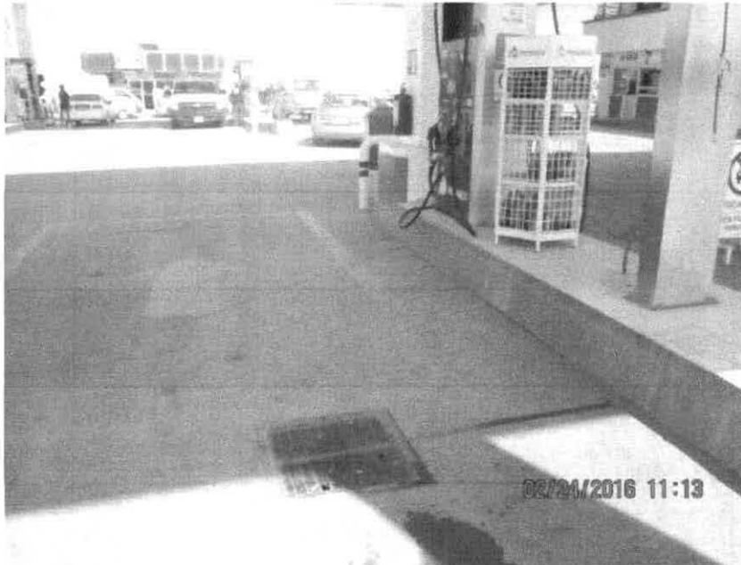
Fotografía No. 16.- Rejilla para colector de aguas aceitosas y con combustibles
