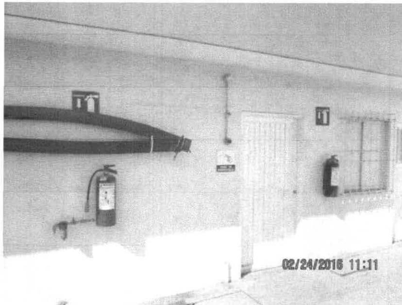
Fotografía No. 12.- Extinguidores en la zona de almacenamiento de combustible.
