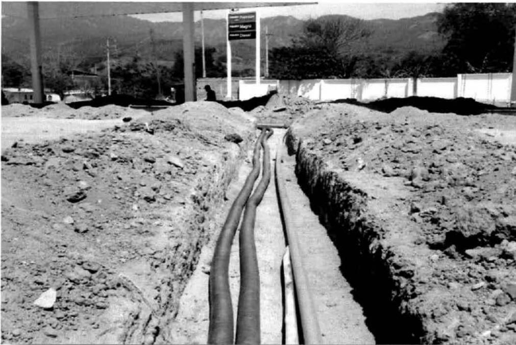
Vista de la instalación de las tuberías para abastecer combustible a los dispensarios y la de recuperación de vapores
