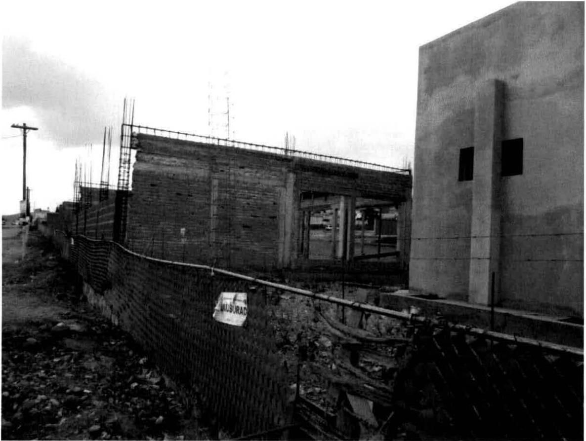
Área que ocupara las oficinas administrativas y las obras asociadas (baños, cuarto de maquinas, cuarto eléctrico, etc.).
