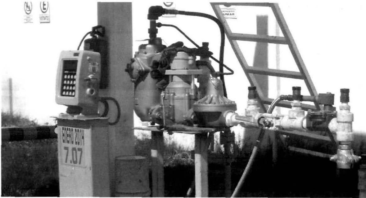
Figura II.2.5. Equipo de Carburación para el Gas L.P.
