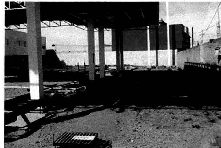
1. Fotos del 2 de enero de 2016. Se ve el avance que lleva la obra en su construcción. A la izquierda se ve el edificio de servicios de la gasolinera; en primer plano estan las islas; al centro se ve la zona de almacenamiento, la cual está cubierta por protección; a la derecha la colindancia con la av. Reforma.
