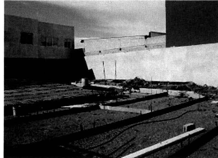
3. Aquí se ve la zona de almacenamiento cubierta, los tanques de almacenamiento de combustibles de la gasolinera proyectada ya están dentro de la fosa. A la derecha se ve la colindancia con una casa.
