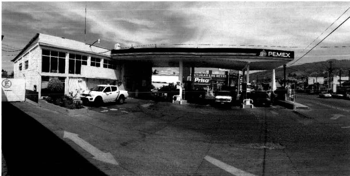
Estación de Servicio en operación, se aprecia edificio administrativo y dispensarios de expendio de gasolinas premium y magna.
