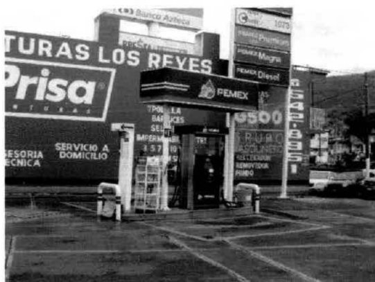
Zona de despacho de Diesel.
