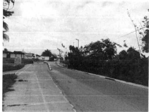
Imagen 5 Acceso por Calle Francisco I. Madero.
