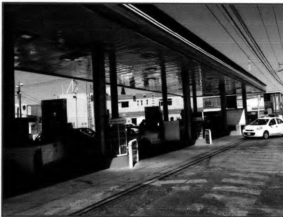
Vista hacia el Norte Se observan estación de servicio 3918, en operación.
