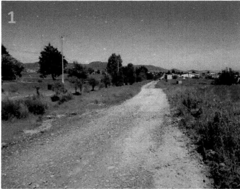
Camino de terracería que da acceso al predio y que entronca con la desviación de la carretera Federal Apan-Calpulalpan, conocida como Chimalpa-Tlalayote.
