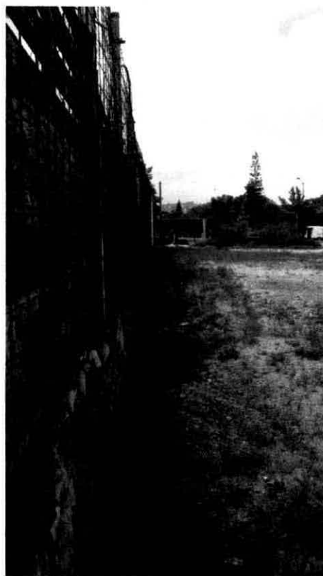
Vista desde el oriente en línea de colindancia sur
