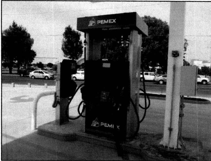
Foto II.2.5.-1. Dispensario triple para las Gasolinas Magna y Premium, y Diesel de bajo flujo
