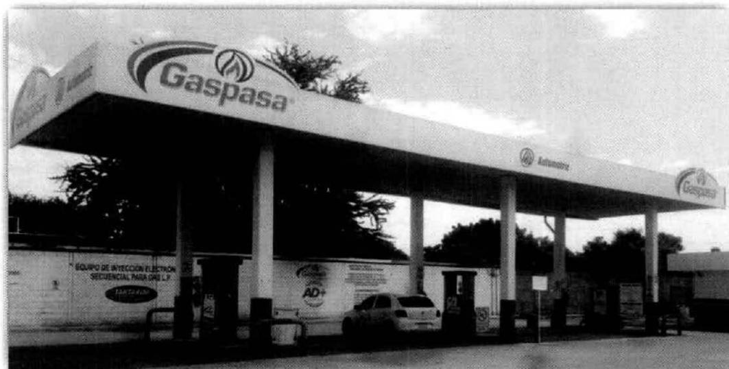
**FIGURA 11:** Área con tres suministros dobles para el llenado de Gas L.P, ubicado en la estación de servicios "Baratas"
