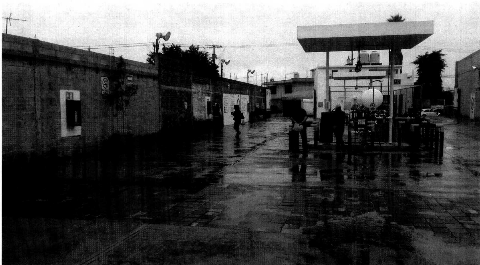
Figura 28. Vista general del Proyecto Estación de Gas L.P. Chimalpa
