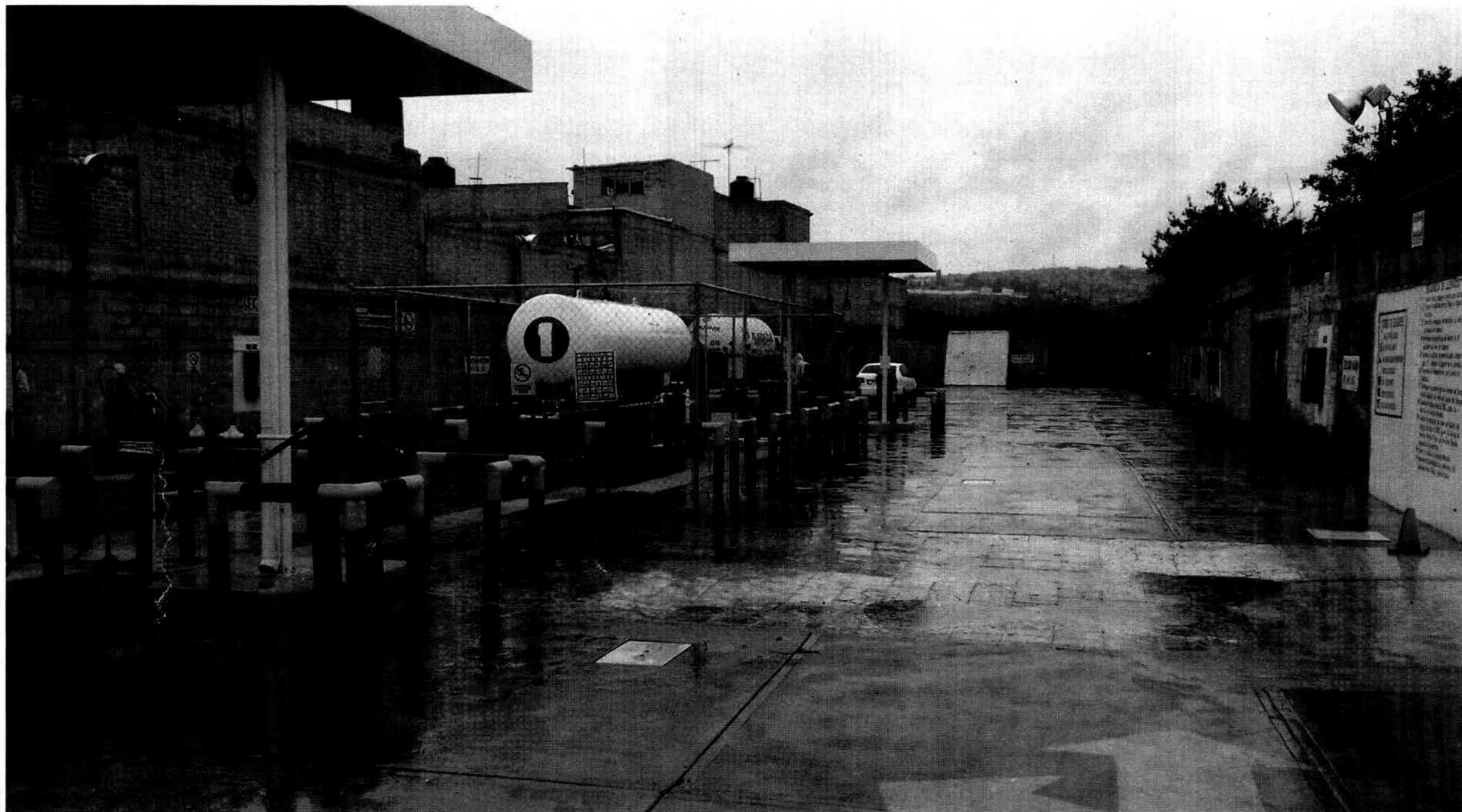
Figura 29. Vista general del Proyecto Estación de Gas L.P. Chimalpa
