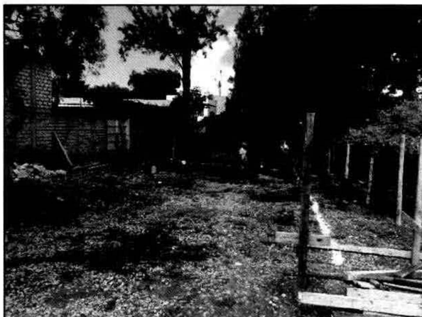
Fotografía II.2.3.a.- Trazo y nivelación con estacas de madera y cal del sitio donde se desplantara el edificio administrativo.
