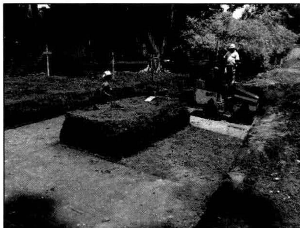
Fotografía II.2.3.d.- Compactación de cepas por medios mecánicos.
