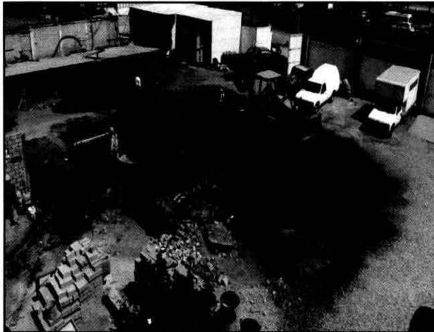
Fotografía II.2.10.c.- Perspectiva del patio de trabajo, donde se aprecia el suelo húmedo, control de dispersión de polvos.
