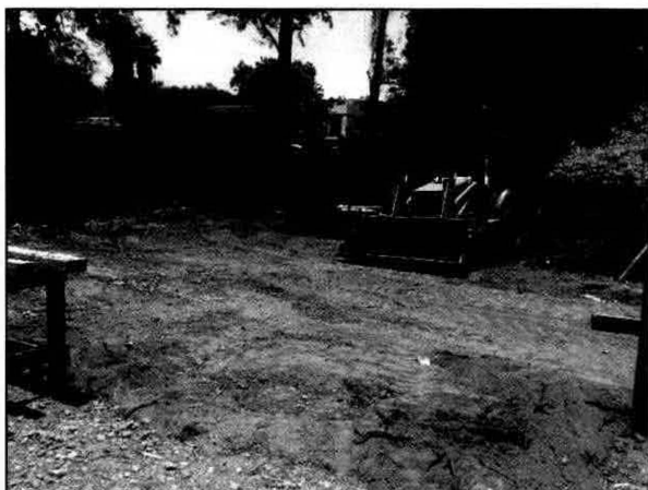
Fotografía II.2.3.b.- Nivelación con maquinaria pesada
