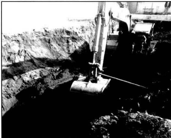
Fotografía II.2.3.c.- Excavación con retroexcavadora en el área de almacenamiento de combustible
