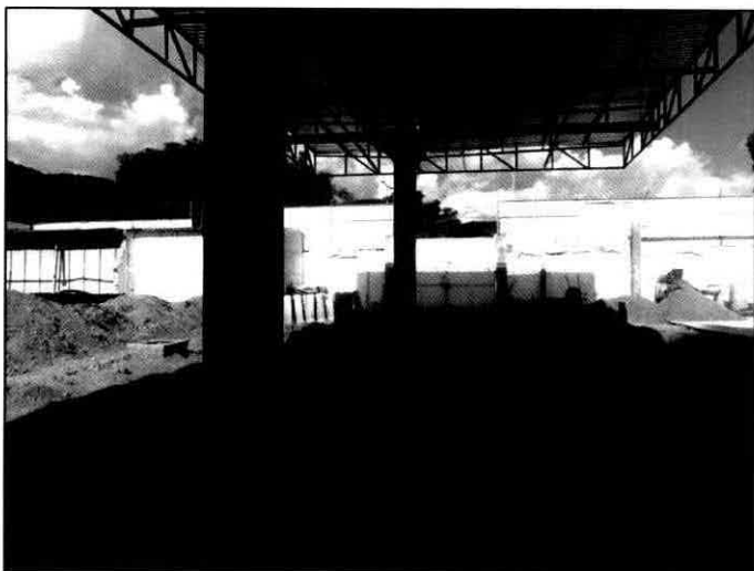
Fotografía II.1.1.d.- Perspectiva del avance de la zona de abastecimiento de combustible.
