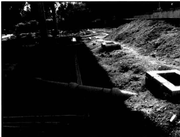
Fotografía II.1.1.f.- Perspectiva del avance del sistema de drenaje en el área de despacho de combustible
