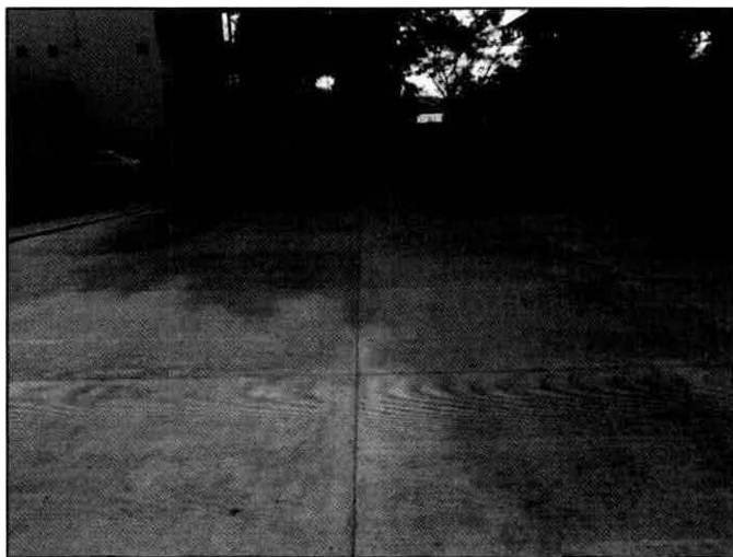
Fotografía II.1.1.e.- Perspectiva del avance de los accesos y circulaciones.
