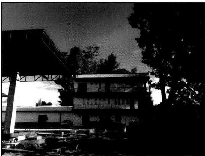
Fotografía II.1.1.b.- Perspectiva del avance del edificio administrativo y de servicios.
