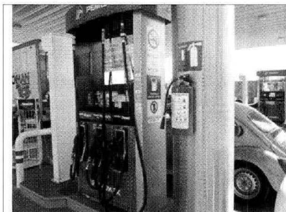
**Foto III.1.3.-11.** Dispensario triple número 1 para las Gasolinas Magna y Premium, y para el Diesel
