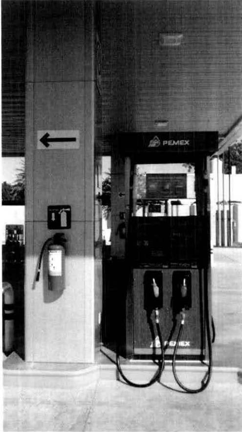
**Figura 22.** Vista fotográfica de los despachadores de gasolina, que cuentan con señalamientos de seguridad, techumbre adecuado, franjas amarillas con las dimensiones adecuadas.
