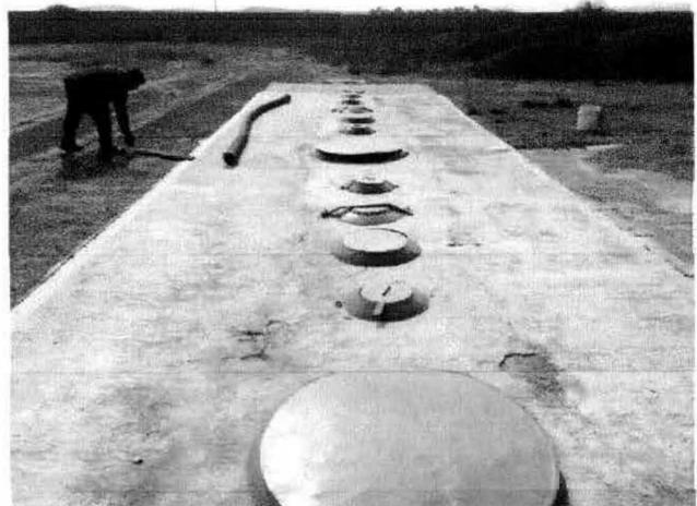
Fosa de concreto armado para almacenamiento de tanque de gasolina magna y premium
