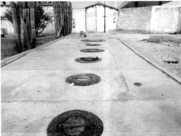
Fosa de concreto armado para almacenamiento de tanque de diésel
