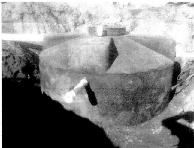
Imagen de la colocación del biodigestor que actualmente da tratamiento a las aguas negras provenientes de sanitarios
