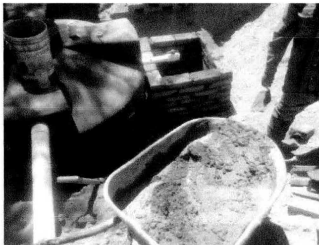
Imagen de la colocación del biodigestor que actualmente da tratamiento a las aguas negras provenientes de sanitarios
