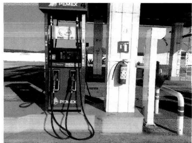
Área de dispensarios de gasolina
