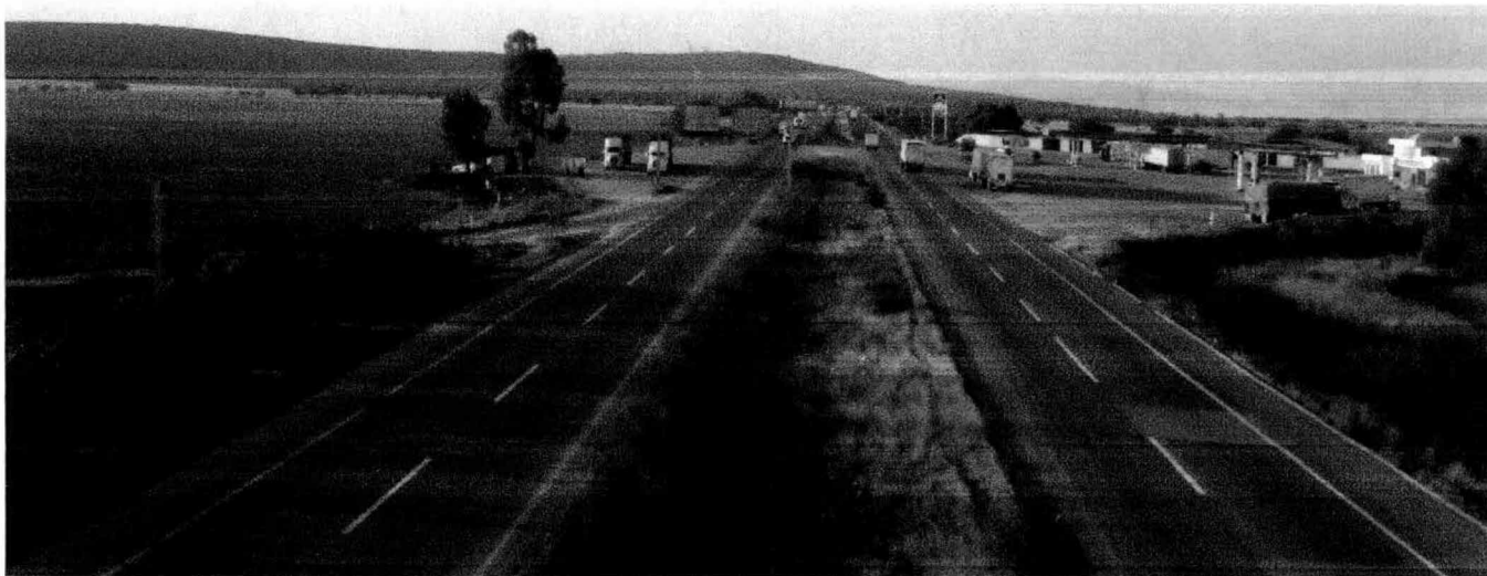
Vista general del área de influencia oeste a la estación de servicio.
