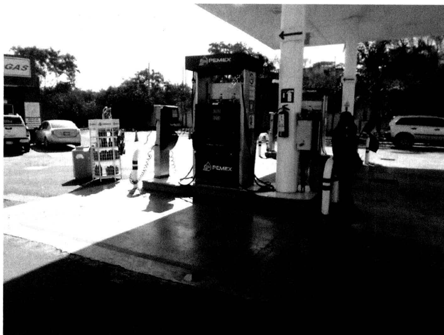
Figura 2. Dispensarios de la estación de servicio.
