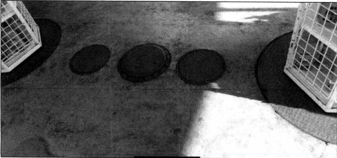
**Figura 12.** Boca de los Tanques de almacenamiento de combustibles, que permiten visualizar los componentes de los mismos, así como la obra civil que requieren para su acomodo dentro de las fosas excavadas para su contención.
