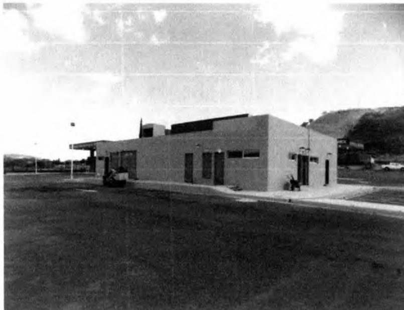
Fotografía 6. Imagen del edificio por la parte trasera, donde se observan los cuartos: de limpios, de sucios, eléctrico y de máquinas.
