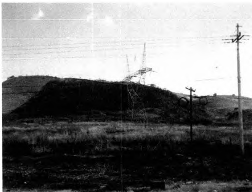
Figura 23. Líneas eléctricas (alta y media tensión) al oriente del predio.
