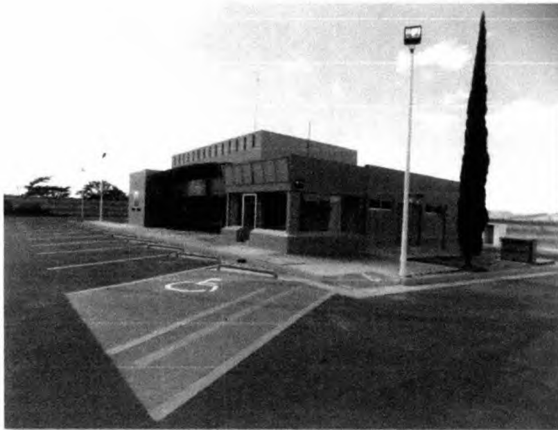
Fotografía 5. Imagen del edificio por la parte frontal, donde se observan los sanitarios, tienda de conveniencia y oficinas.
