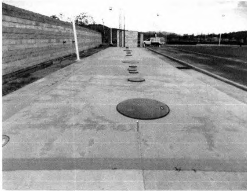
Fotografía 7. Imagen del área de tanques.
