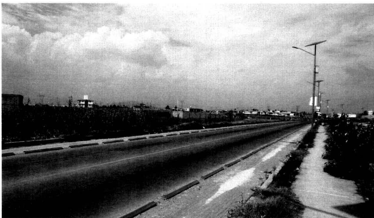
Vista hacia el oeste desde el predio para el proyecto
