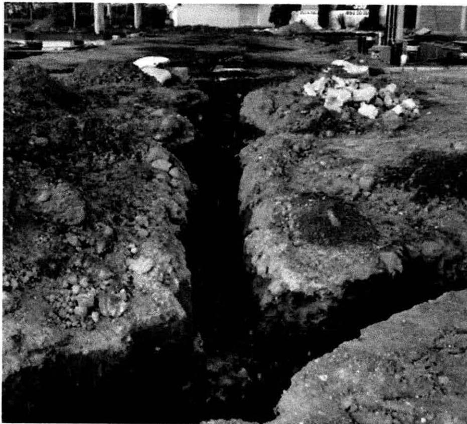
*Imagen 32.- Drenaje de aguas Pluviales*
