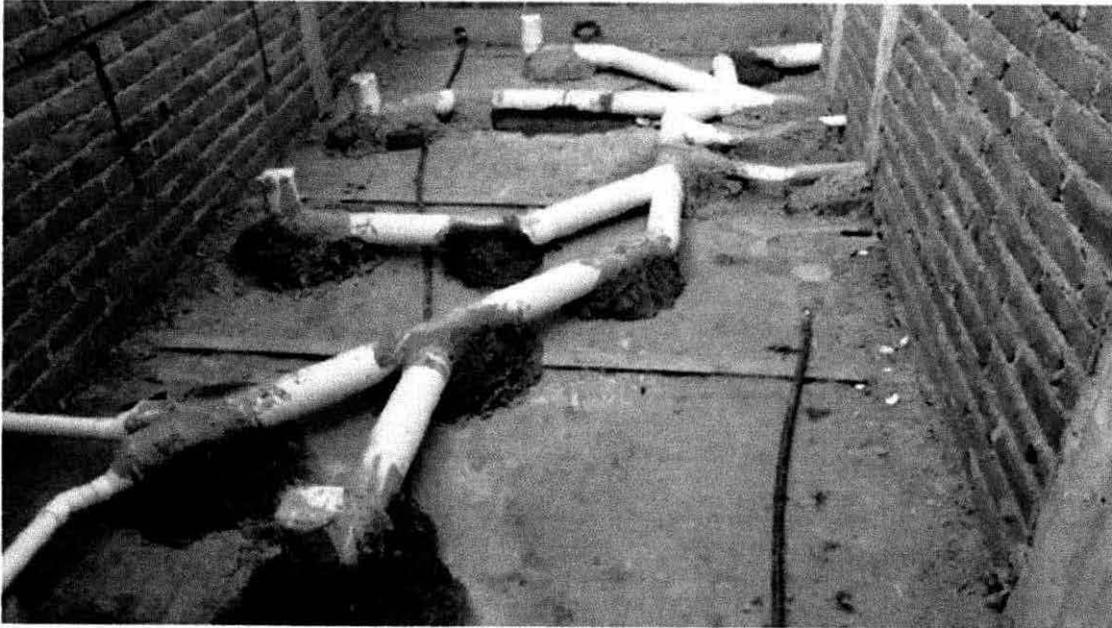
*Imagen 51.-* Instalación hidráulica-sanitaria en el área de baños de empleados
