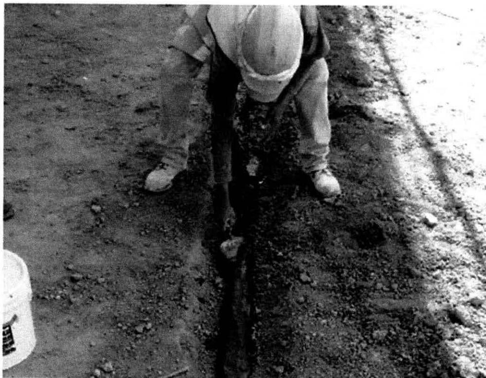
*Imagen 48.- Previo al tapado de cepa para el cable de tierra*
