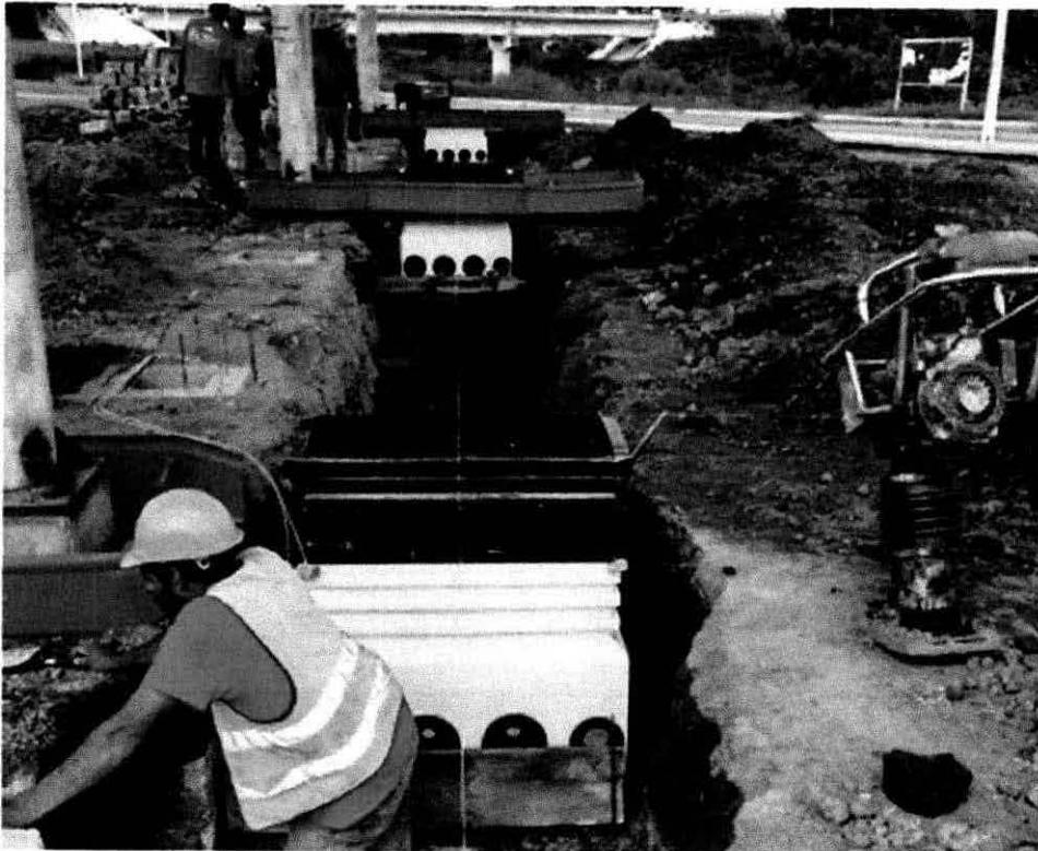
*Imagen 35.- Se abre trinchera y se instalan bases de las islas y contenedores con una pendiente del 1% hacia los tanques (al fondo isla Orienta y al frente la poniente)*
