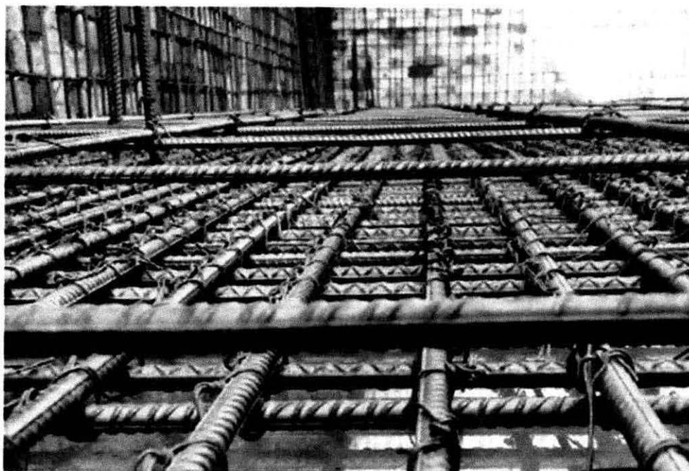
*Imagen 4.- Detalle de armado en fosa*
