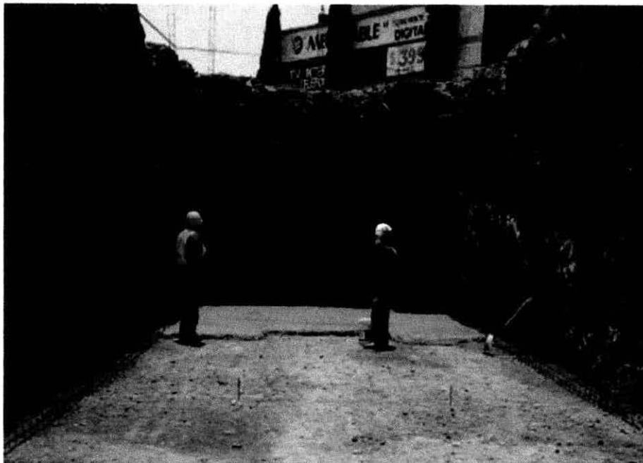
*Imagen 1.-* Excavación y plantilla de fosa
