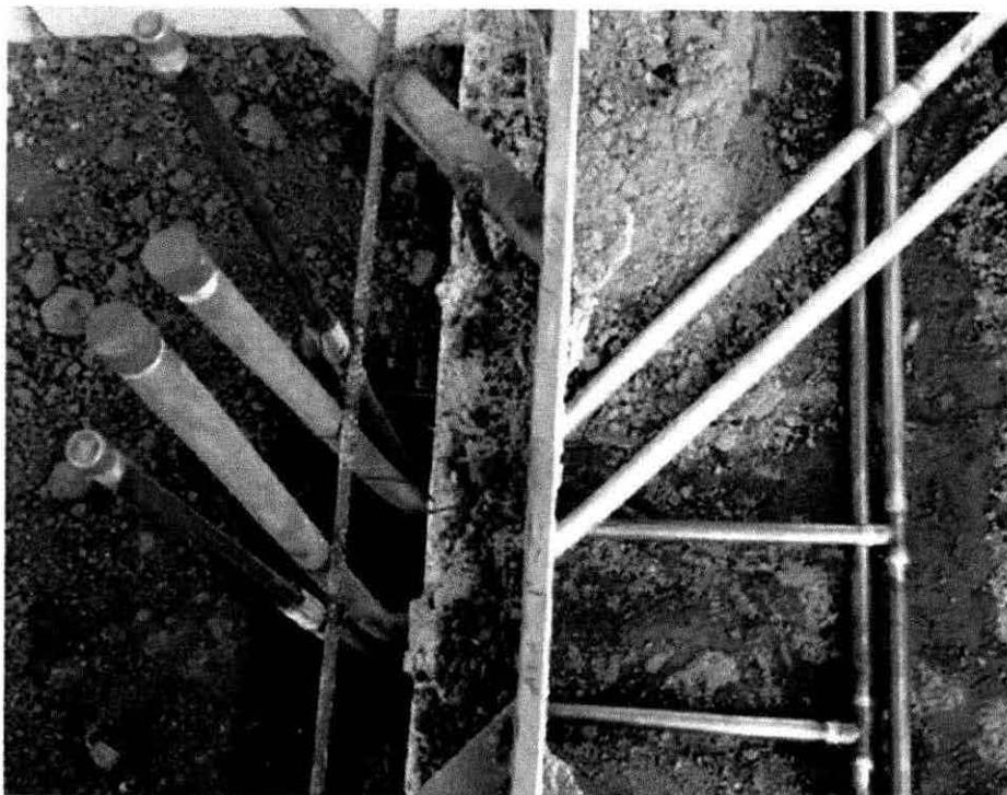
*Imagen 39.-* Instalación de tubería de agua y aire con tubo de cobre ¾ tipo "L"
