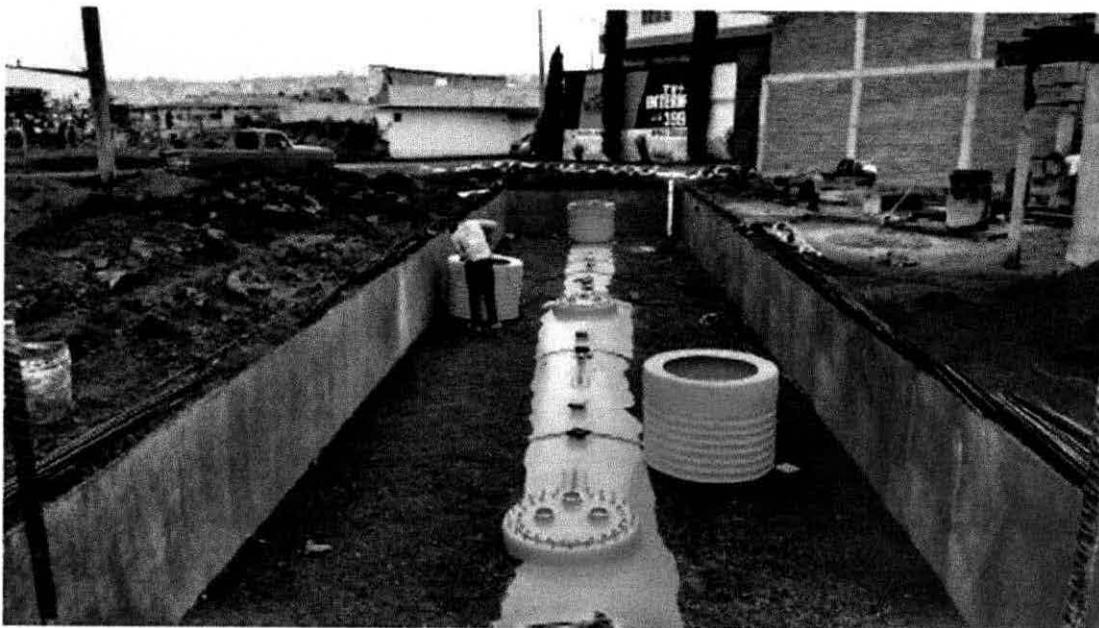
*Imagen 33.- Se empieza a "vestir" los tanque de Magna al fondo, Diesel al centro y Premium*
