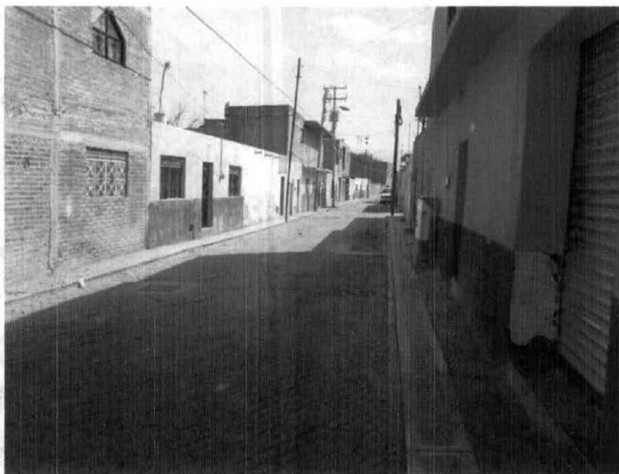
Fotografía 6. Colindancia del predio
