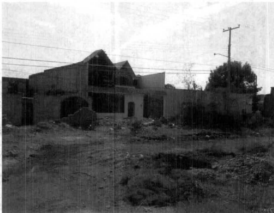
Fotografía 5. Colindancia del predio
