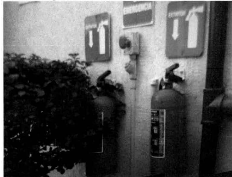
Paro de emergencia
