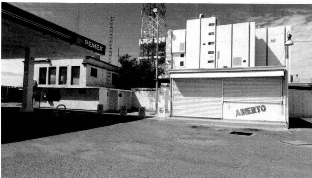
Figura III.16.- Colindancia norte de la Estación de Servicio 1194.
