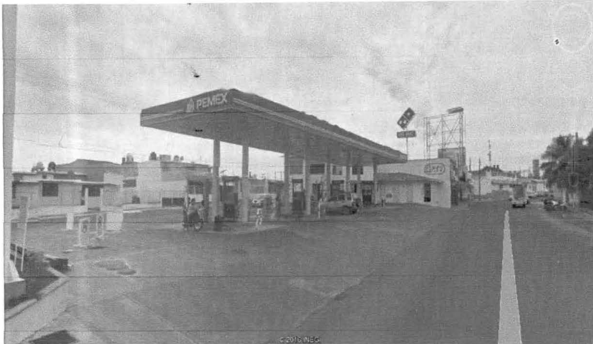
Fotografía 3. Panorámica de la estación de servicios.
