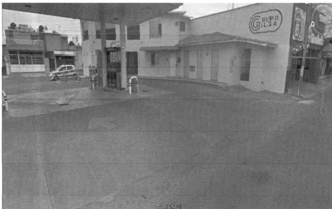
Fotografía 2. Área de bombeo de combustible.
