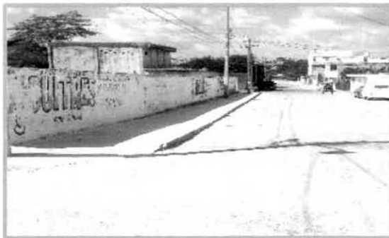
Panorámica de la circulación vehicular sobre la Calle No. 21, lugar donde se construirá la nueva “Estación de Servicio CT12363” .
