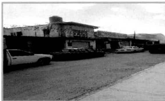
La nueva “Estación de Servicio CT12363” , perteneciente al “Grupo Villamon S.A. de C.V.” , será construida en una zona urbana del municipio de Candelaria, Campeche.
