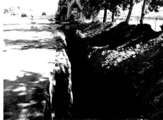
**Fotografías ilustrativas** de los trabajos que se realizarán de la limpieza del terreno y excavación de la zanja para la instalación de la tubería de 6" de Ø del gasoducto en los derechos de vialidades existentes.
