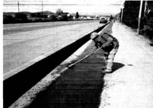
**Fotografía ilustrativa** de los trabajos de alisado y cuidado del fraguado del concreto sobre la zanja del gasoducto.
