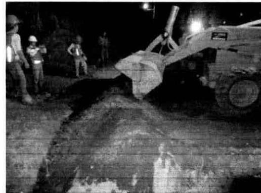
**Fotografías ilustrativas** de relleno de la zanja con el material extraído de ella y la supervisión que se hará de colocarla en el mismo orden en que se extrajo para restablecer el perfil del piso.
