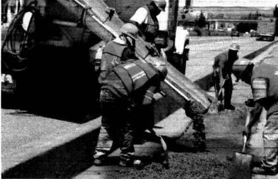
**Fotografía ilustrativa** de los trabajos de recubrimiento con concreto sobre la zanja del gasoducto, si en alguna parte del proyecto se requiere.
