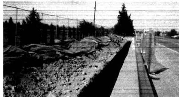
**Fotografías ilustrativas** de los trabajos de cómo se tendería y alinearía la tubería de polietileno del gasoducto a un costado de la zanja.
