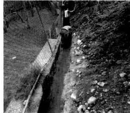
**Fotografía ilustrativa** de excavación de trinchera del personal para tubería de 2" de diámetro de interconexión para red de tuberías menores a domicilios.
