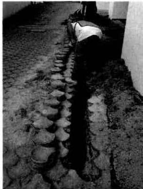
**Fotografía ilustrativa** de excavación de trinchera del personal de la empresa para tubería de distribución a domicilios de 1" de diámetro.
