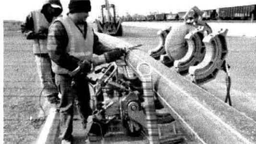
**Fotografía ilustrativas** de los trabajos que se realizarán del proceso de soldadura de los tramos de tubería de polietileno mediante termofusión
