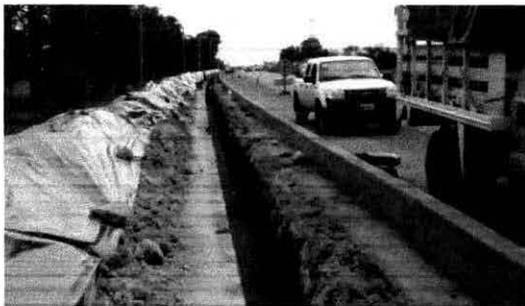
**Fotografía ilustrativa** material de excavación junto a la zanja, recubierto por plástico para prevenir erosión, cuando por alguna razón anómala implique que se quede más de 48 hrs. expuesto.
