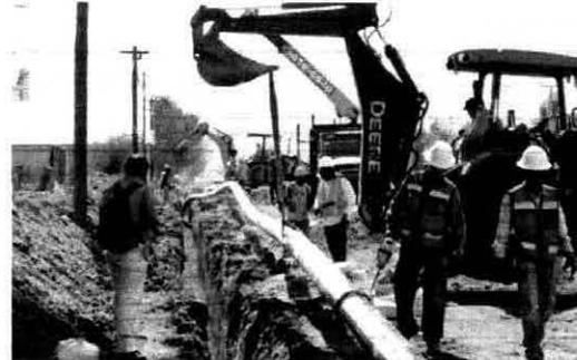
**Fotografías ilustrativas** de los trabajos que se realizarán de disposición de la tubería ya soldada y alineada dentro de la trinchera, con supervisión continua para asegurarse que todo se haga según lo establecido en el proyecto.
