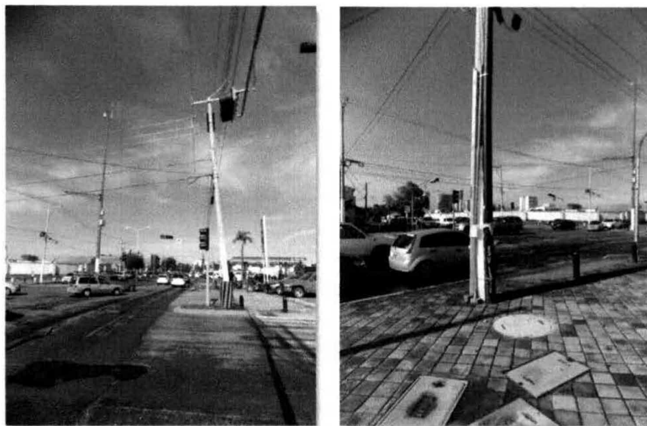
Figura 21. Línea eléctrica que colinda con el proyecto.
