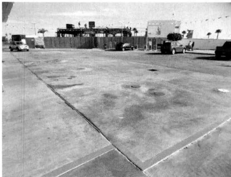
Figura 10. Imagen de la ubicación de la fosa y los tanques de almacenamiento de combustibles.
