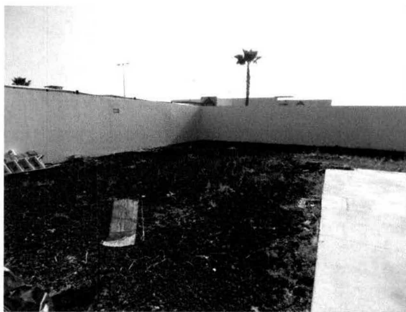
Figura 16. Imagen del muro perimetral.
