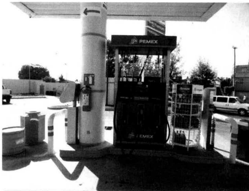
Figura 18. Imagen de uno de los dispensarios con que se cuenta en la gasolinera.
