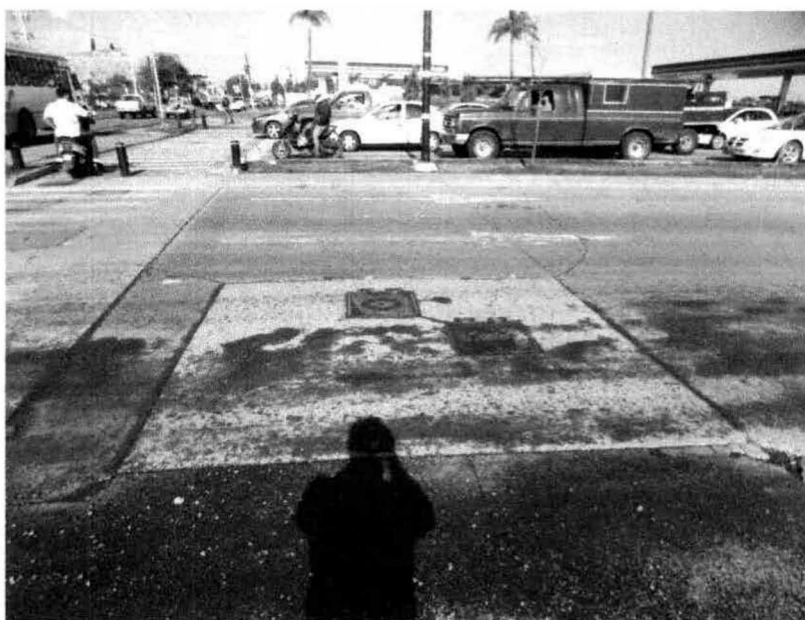
Figura 23. Registros de agua potable enfrente del predio.
