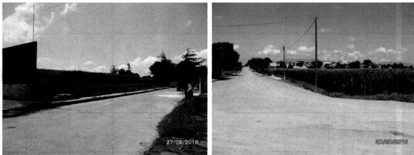
Fotografía 19 y 20.- Se observa en colindancias uso agrícola.
