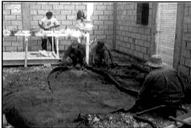
Figura III. 42. Instalación de capa de polietileno.
