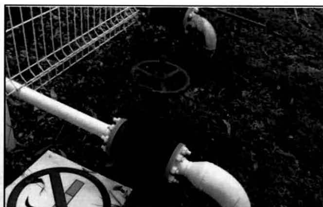
Figura III. 34. Válvulas de corte a la salida de las dos líneas de regulación (a cogeneración y a quemadores).
