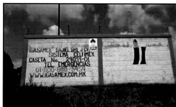
Figura III. 12. Estación de Medición y Regulación del punto de interconexión (vista lateral).
