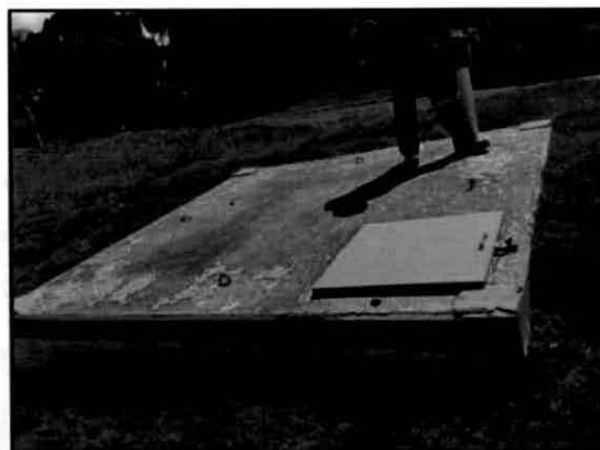
Figura III. 10. Tapa del Registro de concreto.
