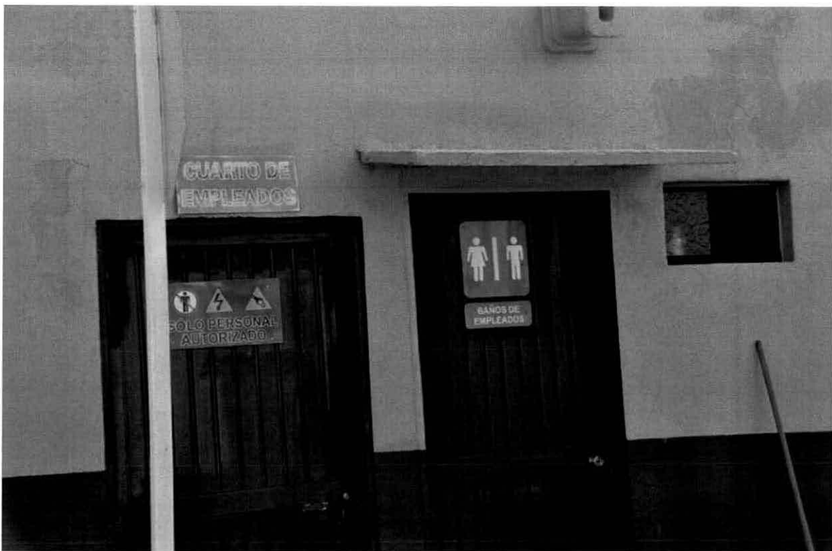
Fotografía 8. Cuarto de empleados y servicio de sanitarios para empleados de la Estación de autoservicios
