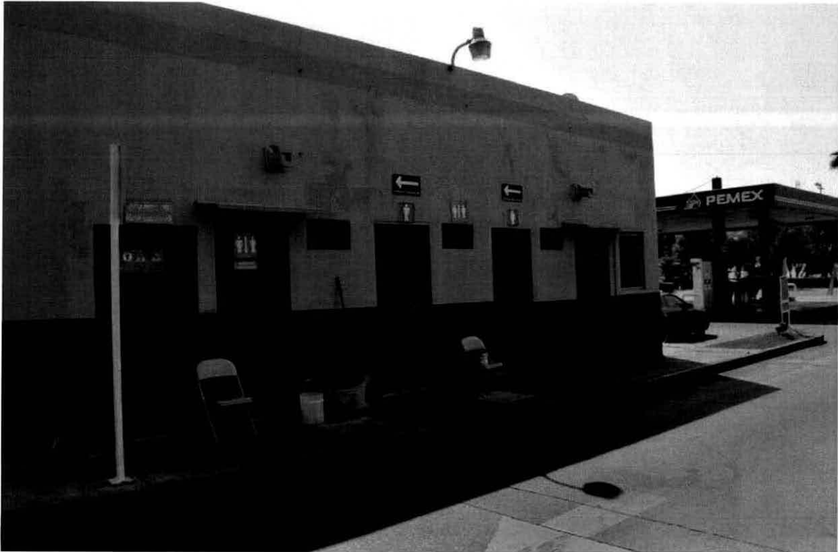
Fotografía 7. Servicio de sanitarios para clientes de la Estación de autoservicios
