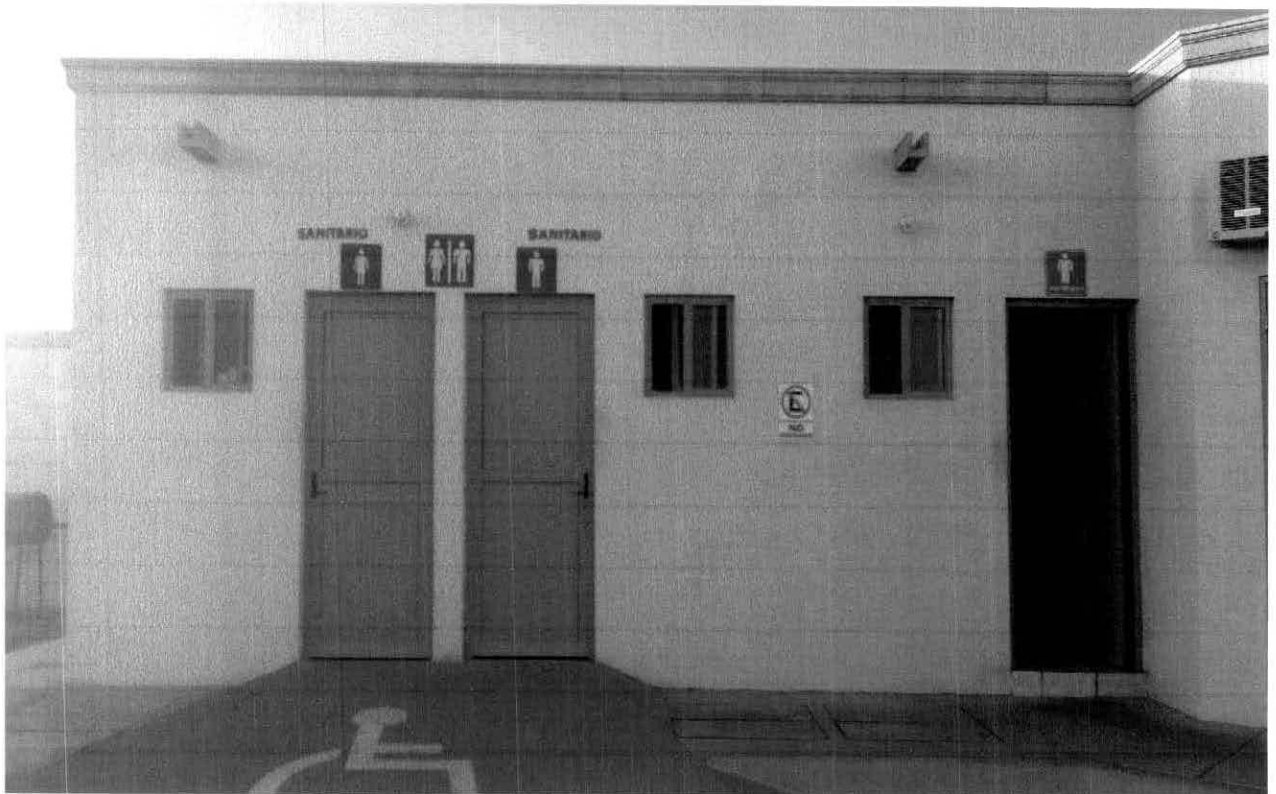
SANITARIOS EMPLEADOS Y PUBLICO EN GENERAL
