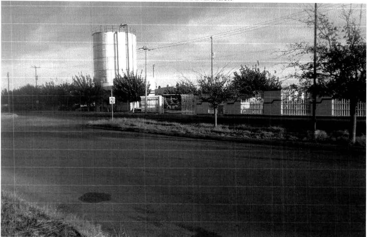
VISTA DE ENTRADA A MAQUILADORA FRENTE DE LA ESTACION
