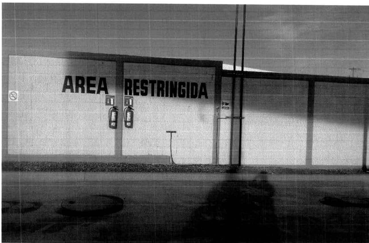
AREA DE TANQUES Y TUBOS DE VENTEO DE VAPORES
