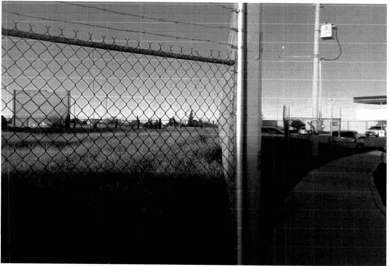
Colindancia Norte Predio Baldio Sin Uso
