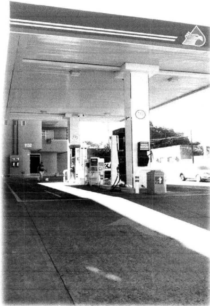
Fotografía del frente de la estación se aprecian las bombas de la estación y al fondo el edificio de oficinas.
