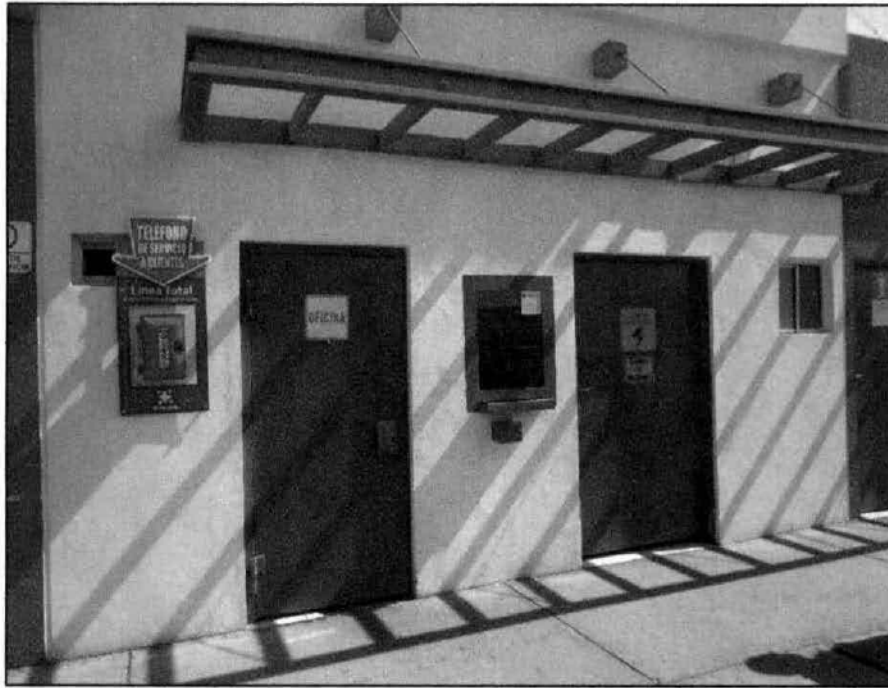
Imagen 3. Oficinas administrativas, cuarto de máquinas y cuarto eléctrico.
