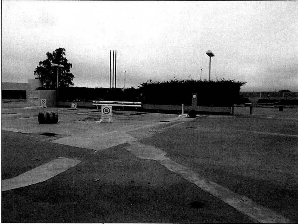
Figura 3. Área de tanques de almacenamiento.
