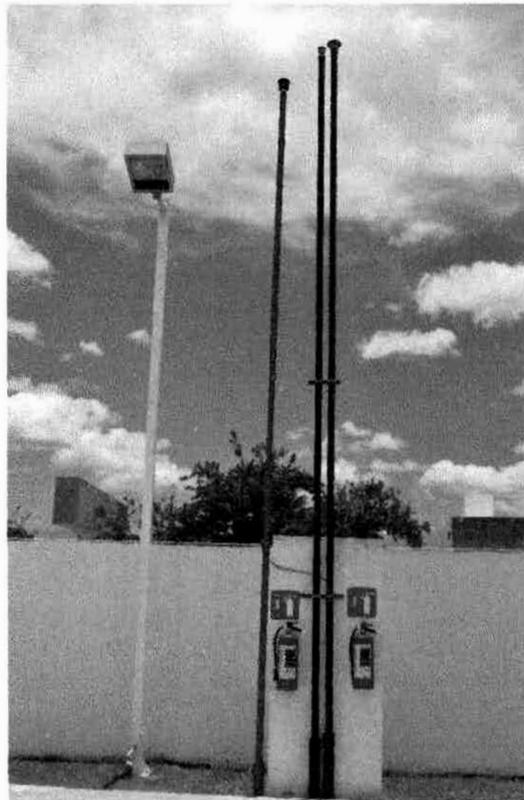
8.-Se observa los tubos de venteo aterrizados a tierra física, los extintores con señalización adecuada y la lámpara contra explosiones.
