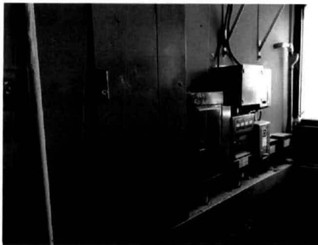
Foto 5. Cuarto de Controles Automatizados.
