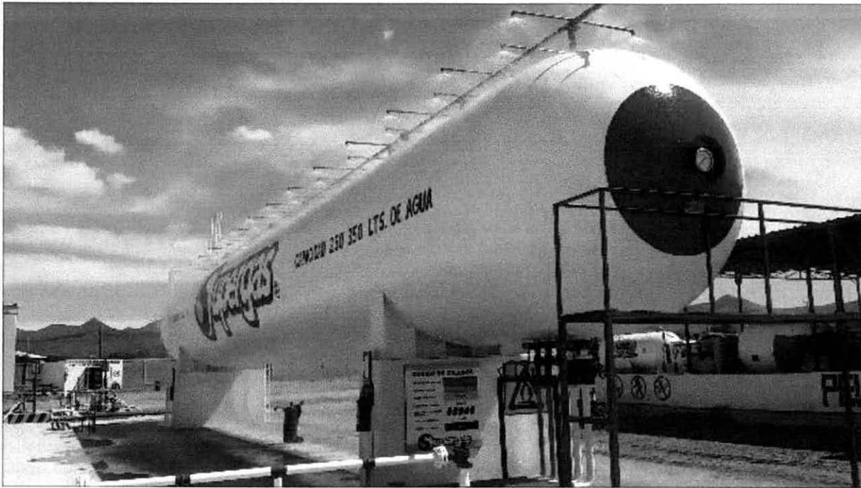
Foto 3 Tanque de almacenamiento, sobre bases y plataforma de concreto.
