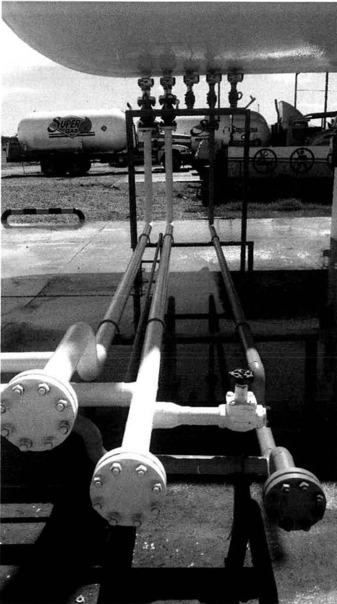
Foto 8 Arreglo de tuberías entrada a tanques
