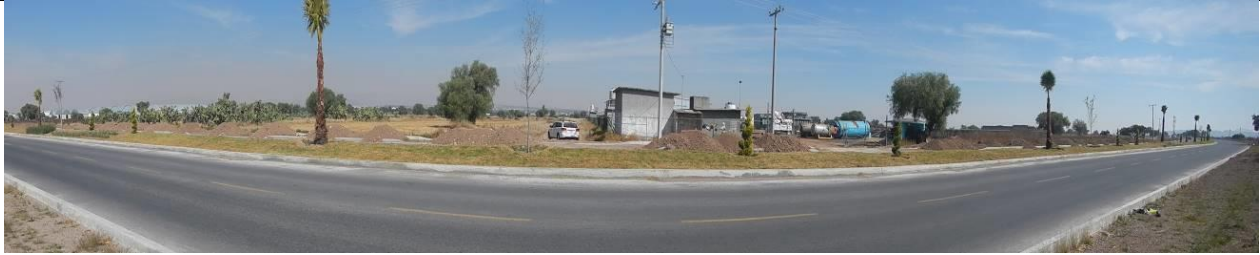
Figura 5.7. Vista de la entrada al predio donde se pretende construir la Terminal
