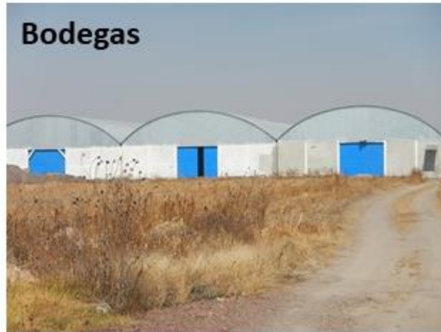
Figura 5.3. Vista las instalaciones ubicadas al Oeste del predio de la Terminal
