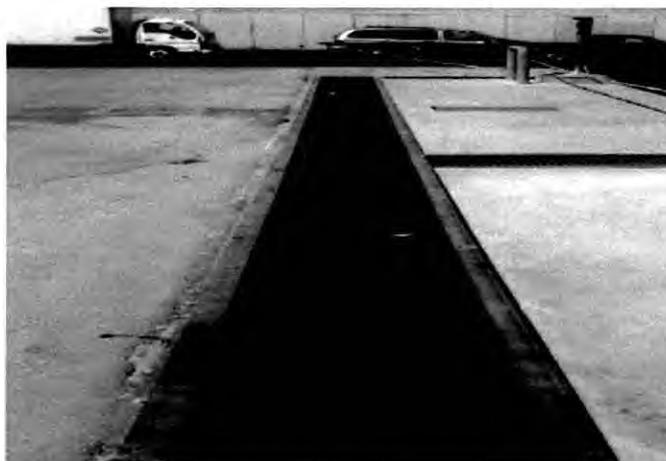
**Figura 29.** Trinchera de Instalación Interna de Alta Presión.
