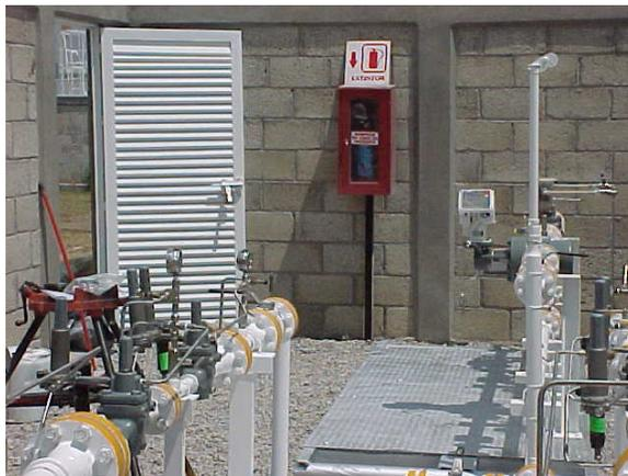
*Figura 5 Extintor tipo ABC en caseta de medición y regulación (Interconexión)*
