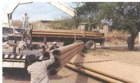
*Figura 6 Transporte y manejo del tubo*
