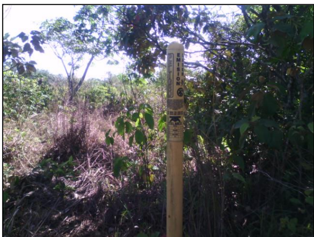
3.- Durante el recorrido se encontró postería de TELMEX indicando la presencia de fibra óptica.
