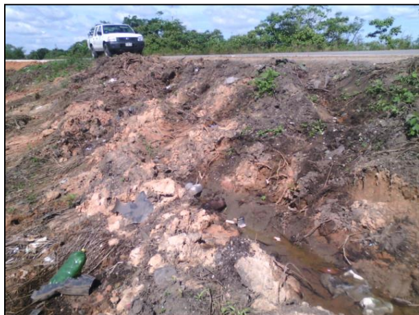
2.- Derecho de vía de la Carretera Federal No. 180, afectado por el derrame de Diésel.
