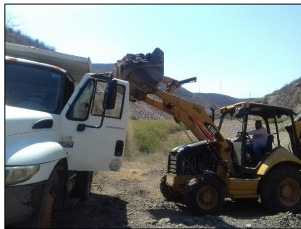
10.- Depósito de material edáfico afectado a camión de volteo para su traslado a celda provisional.
