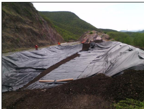
3.- Construcción de celda provisional con bordos de material edáfico libre de contaminantes.
