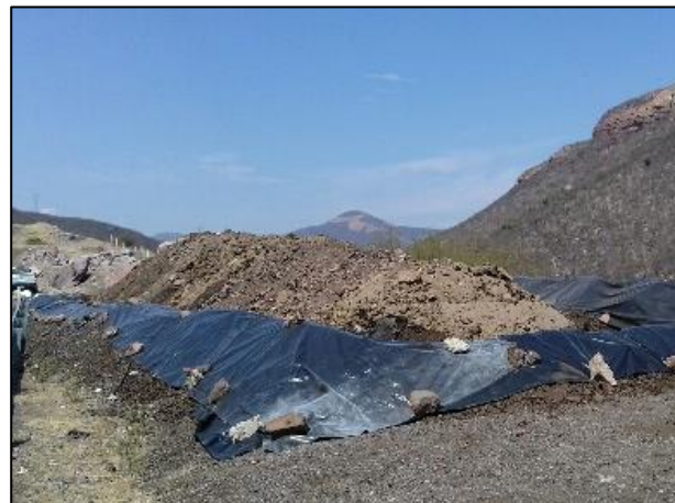
12.- Celda provisional con medidas de 31 m de largo, 9 m de ancho y 1.5 m de altura.
