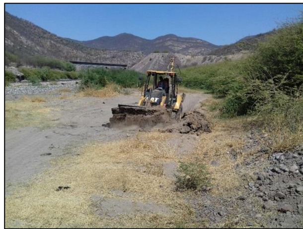
6.- Extracción de material edáfico afectado en la zona del cauce del Río Balsas.
