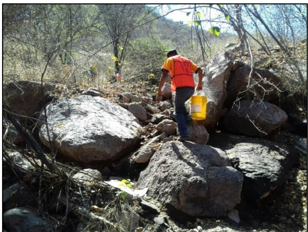
5.- El material edáfico afectado extraído fue colocado en cubetas para su acarreo a celda provisional, esto con apoyo de recurso humano.
