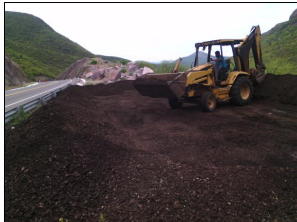
2.- Adecuación del sitio para construcción de celda provisional.
