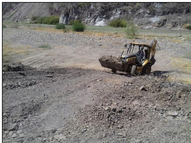
9.- Acarreo de material edáfico afectado con ayuda de retroexcavadora.
