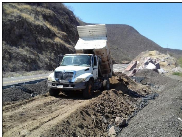
11.- Acarreo y depósito de material edáfico afectado a celda provisional.
