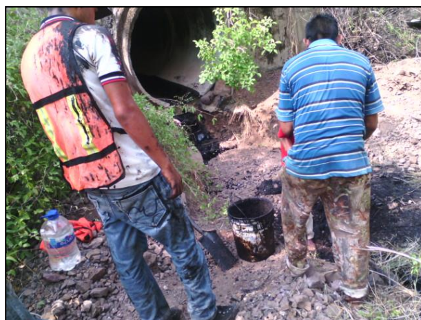
4.- Extracción manual del material edáfico afectado que se encontraba en la tubería de concreto y en la salida de la misma.
