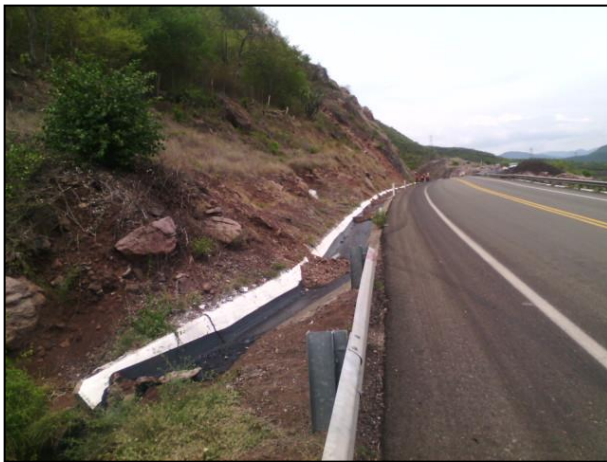
1.- Canaleta de concreto por donde se desplazó el Combustóleo hasta desembocar en suelo natural.
