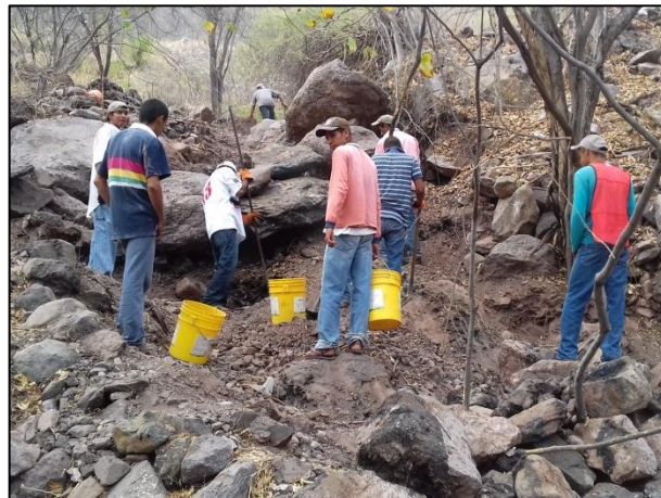
8.- Extracción de material edáfico afectado en zonas con difícil acceso a maquinaria pesada.
