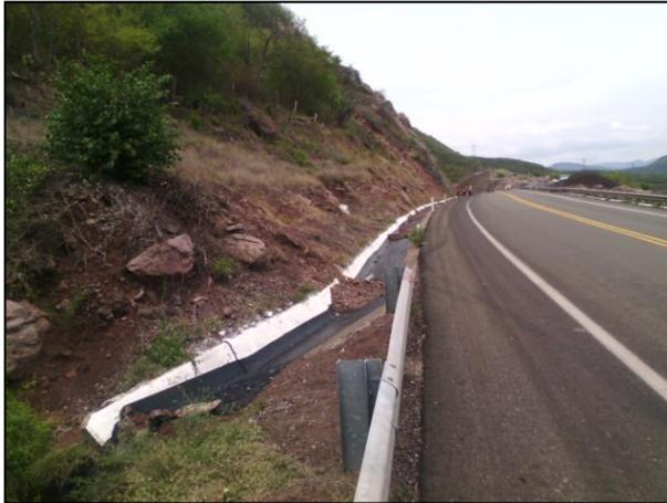
1.- Canaleta de concreto por donde se desplazó el Combustóleo hasta desembocar en suelo natural.
