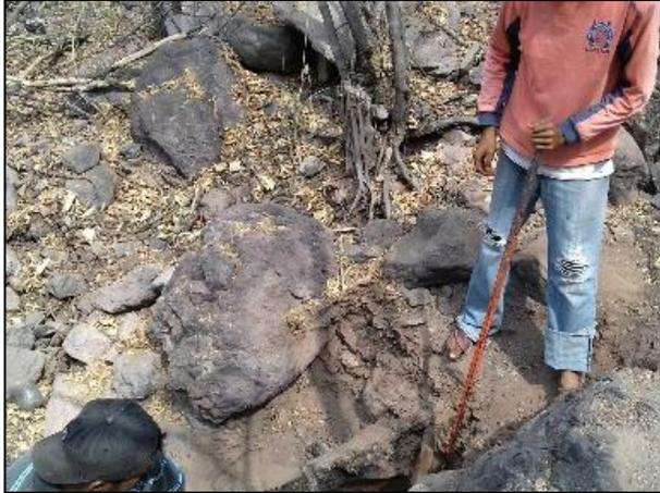
7.- Con apoyo de picos y palas se extrajo el material edáfico afectado con Combustóleo que se encontraba entre las rocas.
