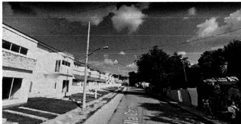
Vista panorámica de la calle Villacabra que colinda con el área de estudio donde se va a construir la Estación de Servicio
