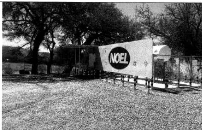
Figura 5. Vista de la Estación de carburación.
